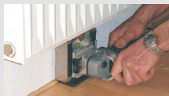
Dehnfugen schneiden unter Heizkörper
