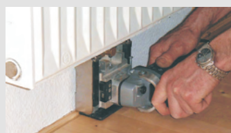
Dehnfugen schneiden unter Heizkörper
