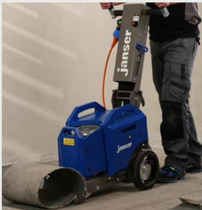
Ablösen von textilem Bodenbelag mit selbstschneidender U-Klinge
