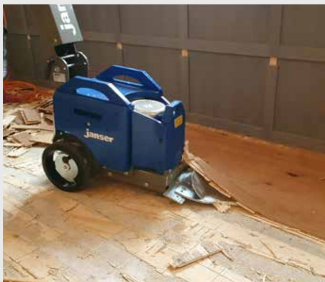
Einsatz der Parkettklinge - Dynamische Form zur Entfernung von allen Arten von Parkettböden geeignet. Massiv-Parkett, Zwei- und Mehrschichtparkett
