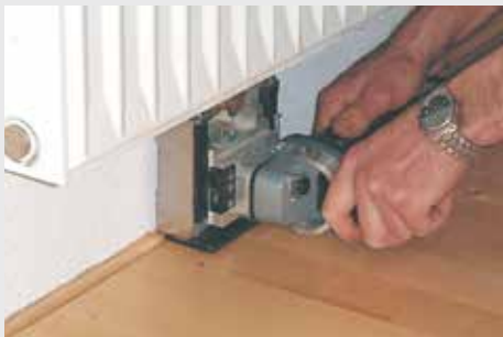
Dehnfugen schneiden unter Heizkörper
